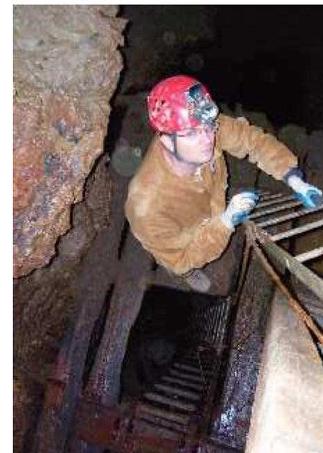
Fig. 1.20 - Uno dei pozzi interni con le scale metalliche affiancate alle vecchie scale di legno (Foto Finocchiaro)
